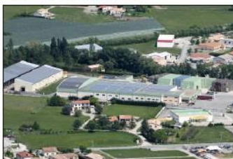
Les acteurs privés (ici, la coopérative fruitière de Laragne avec ses toits couverts de panneaux photovoltaïques) seront intégrés à la démarche.
